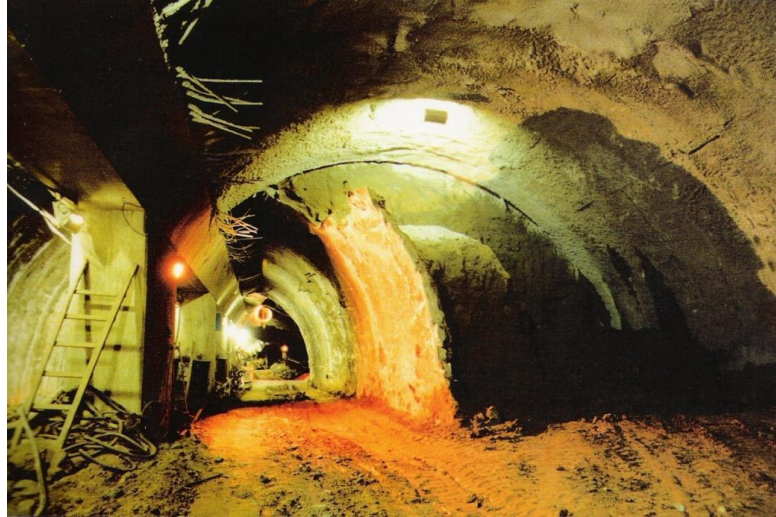
Figura 50 - Vista do Interior da Estação Vila Madalena durante escavação
