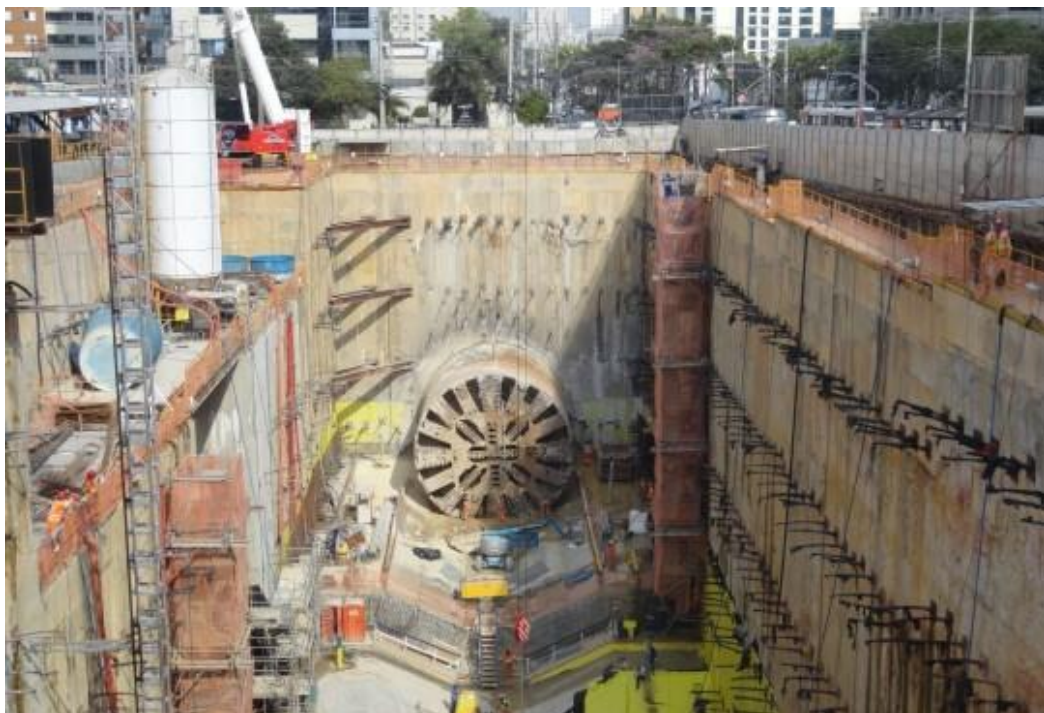
Figura 54 - Tuneladora chegando à Estação Eucaliptos da linha 5-Lilás
